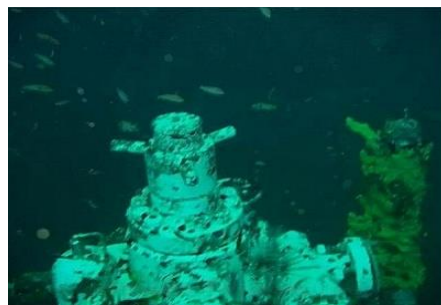
海底石油装置海生物清洗作业
