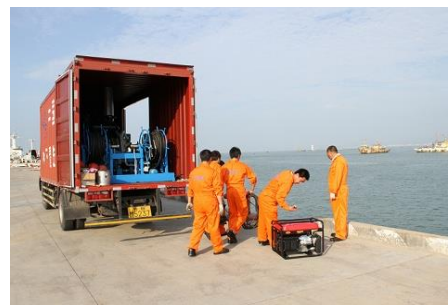
三亚海监船船体清洗工程
